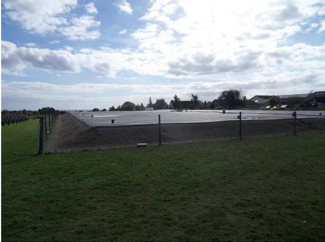
*Figura 14. Il vecchio accumulo a fossa completo di copertura plastica*
