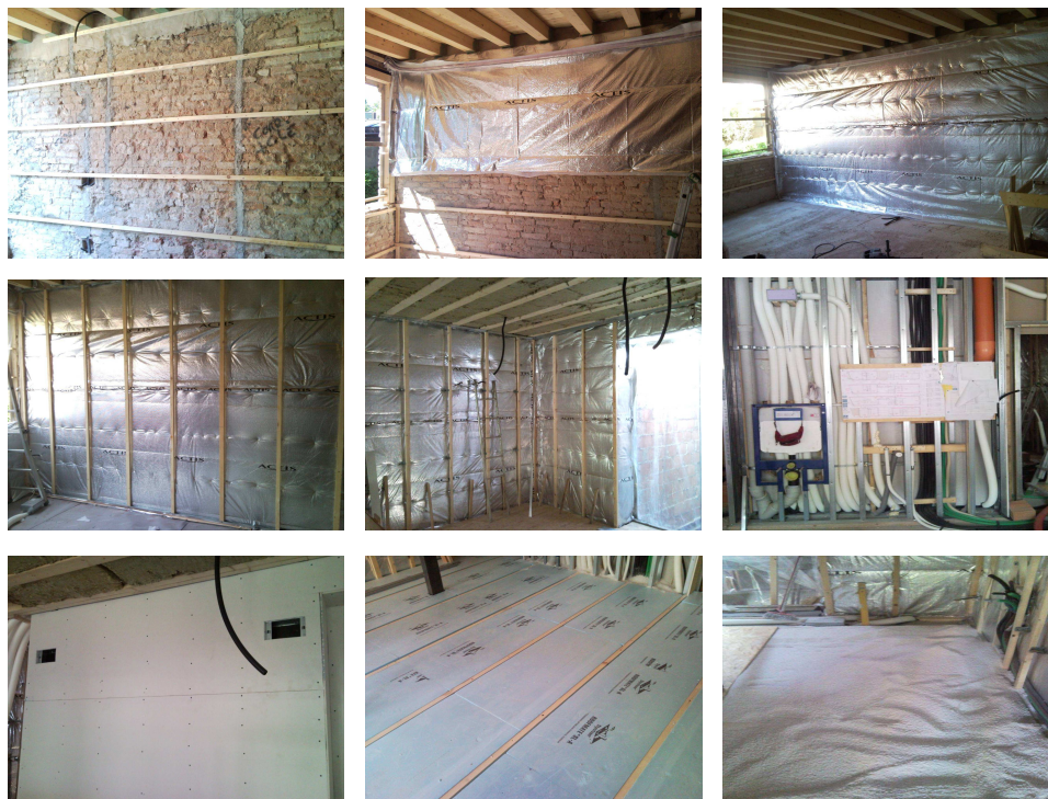
Fig. 4 Fasi di posa dell'isolante termoriflettente, dell'isolamento con lana di roccia dell'intradosso dei solai in legno, dei condotti e terminali impiantistici nei cavedi tecnologici, dell'isolamento contro terra in polistirene, dell'isolamento all'intradosso dei solai in perlite espansa.
