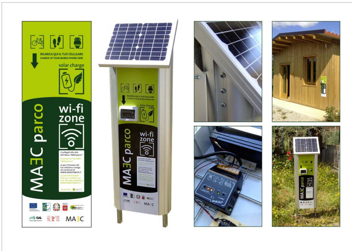
Figura 4 – Una delle stazioni di ricarica installate lungo il percorso
